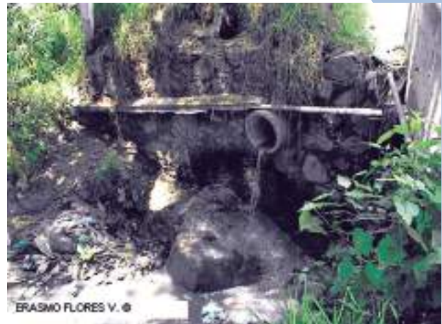
FOTO. 6.1. DESCARGA DE AGUAS RESIDUALES AL RÍO.
