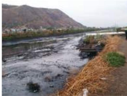
El Canal La Compañía, visto desde arriba en esta foto, está conformado principalmente por azolve, con muy poco tirante, y, por lo tanto, no aguantó el caudal de lluvias.
